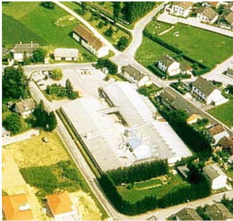
... unser Produktionsgebäude von oben ...
